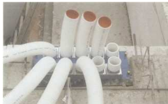
Comfotube – bela, znotraj gladka in zunaj rebrasta cev iz novega, čistega HDPE-ja
