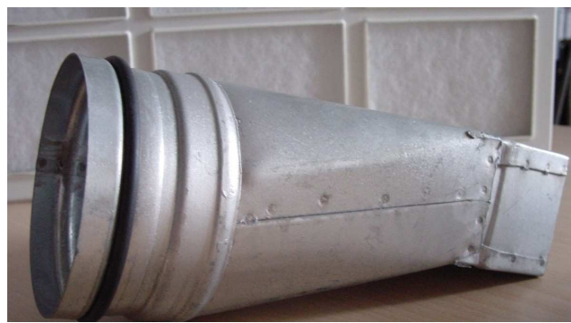
Pločevinasti kanal - prehodni kos okrogel-oglat
