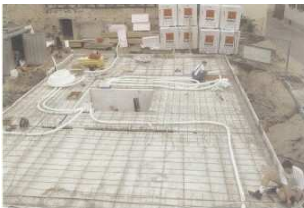
Comfotube – bela, znotraj gladka in zunaj rebrasta cev iz novega, čistega HDPE-ja
