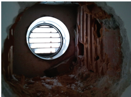
Na fasadi se izvede preboj za zajem zraka DN 125 mm.
