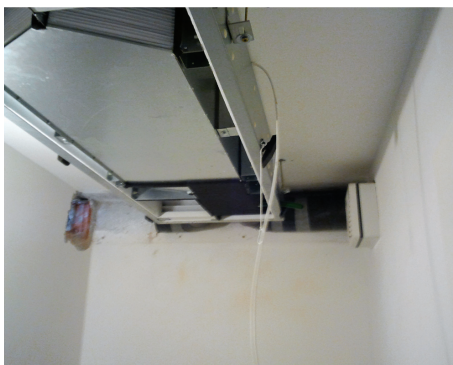
Rekuperator se vgradi pod strop utilitija ali kopalnice.
