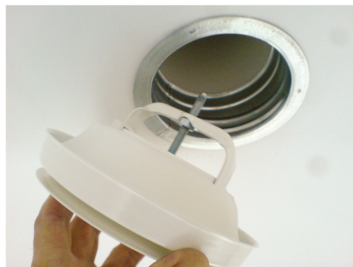
Na koncu se vgradijo dovodni difuzorji in odvodne rozete.
