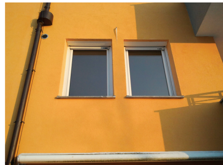
Fasadna rozeta za zajem zraka na fasadi ni moteča, lahko se jo prebarva v barvo fasade.
