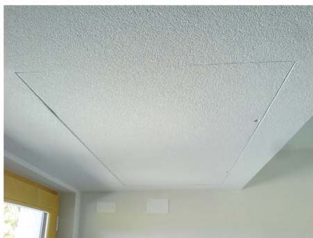
Suhomontažna obloga z revizijskimi vratci za menjavo filtrov zmanjša maksimalen hrup naprave s 30 na 19 dB.
