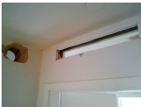
Primer sanacije stanovanja: strop v hodniku se spusti za razvod fleksibilnih cevi, najprej se izrežejo odprtine.
